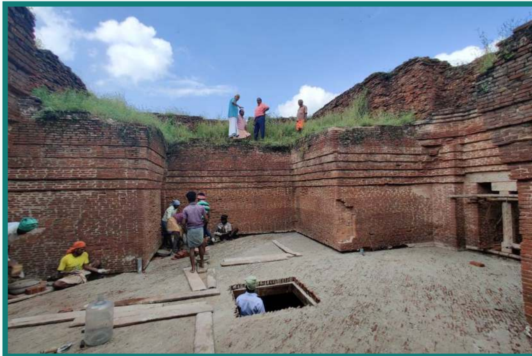
The 2nd Tier (இரண்டாம் நிலை) ceiling is built over this 1st Tier (முதல் நிலை) Madras-Terrace ceiling
